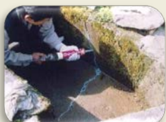
水路のひび割れ補修
