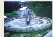
畜産環境対策施設
