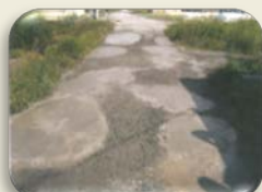
農道の窪みの補修
