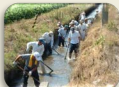
水路の泥上げ
