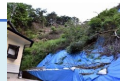
豪雨の度に 土砂崩れが多発
